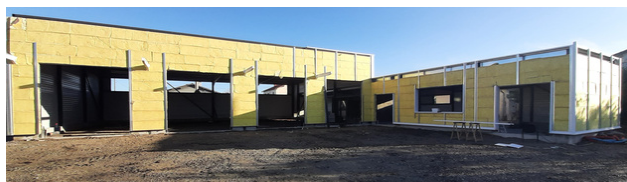
Construction du Centre Technique Municipal - Rue du Château d'eau
